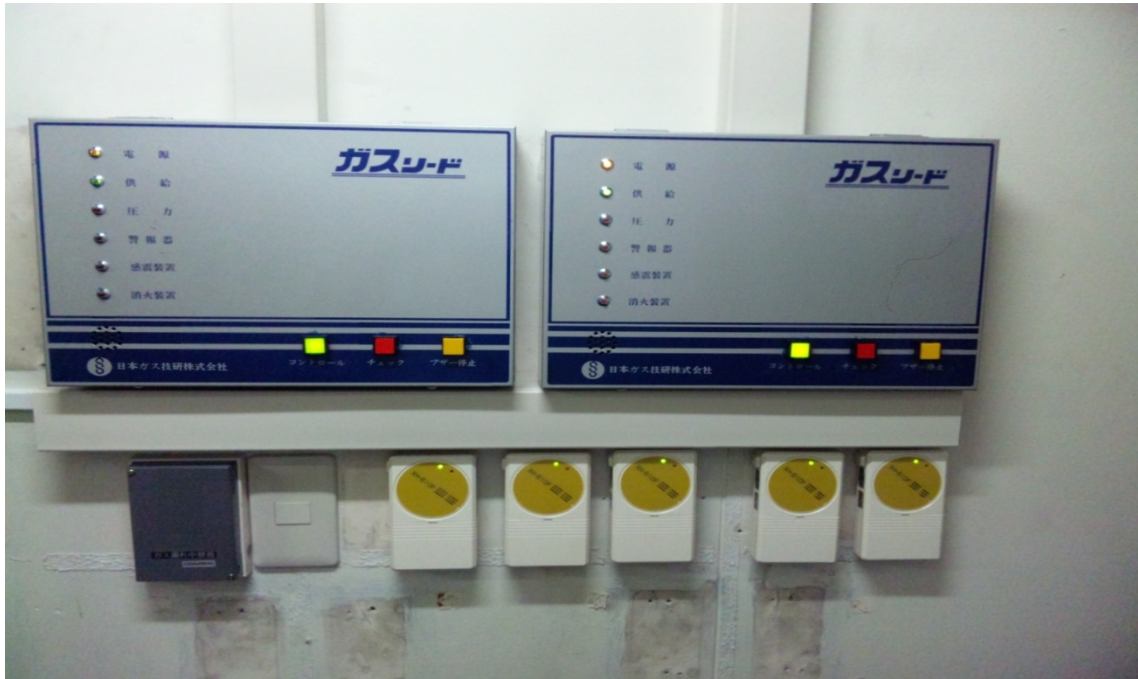
ガスリード SS-II (GSE 社) / ガス漏れ警報器 XH-610F / 中継器 (新コスモス電機社)
